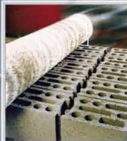
Großformatige Mauerblöcke sind mit Nut- und Feder ausgestattet. Die Stoßfuge bleibt mörtelfrei.
